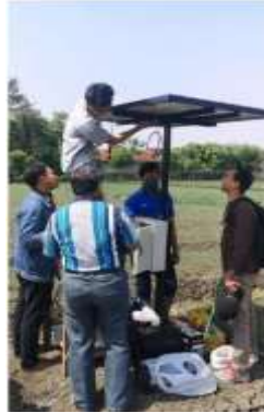
Gambar 1. Pemasangan panel tenaga surya
